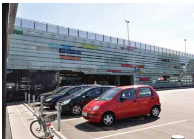
Wielopiętrowy parking w centrum handlowym Nørreport Centeret w Holstebro, Dania
