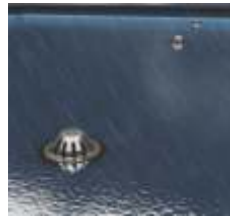
Wpust dachowy grawitacyjny typ 401.10 z kołnierzem nierdzewnym do papy bitumicznej
